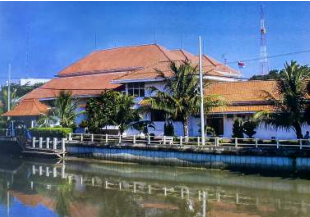
Gambar: Gedung Grahadi dari arah Kalimas tahun 2008 (sumber: Tim HNK)
