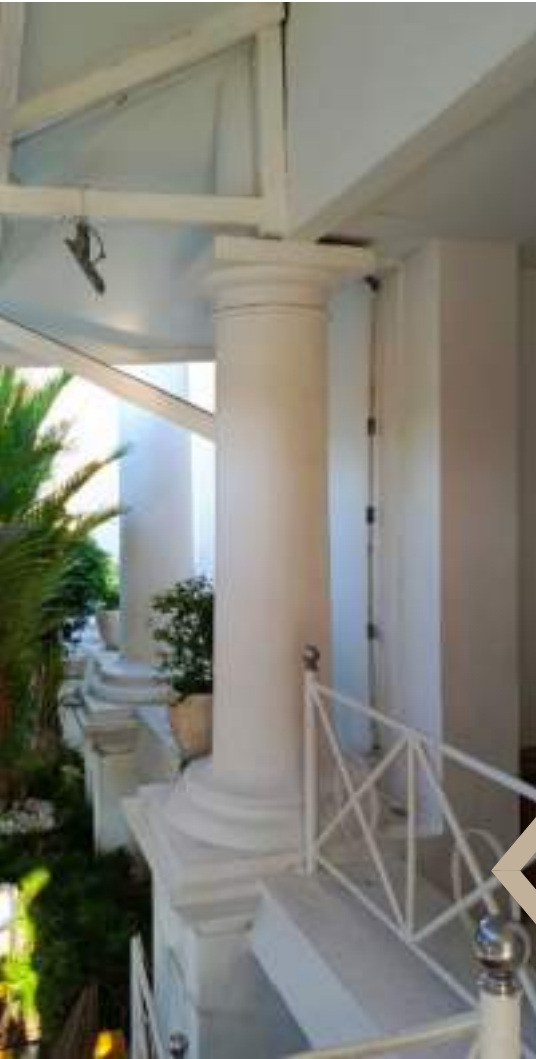
Gambar: Tampak Kolom Sisi Belakang Gedung Grahadi
