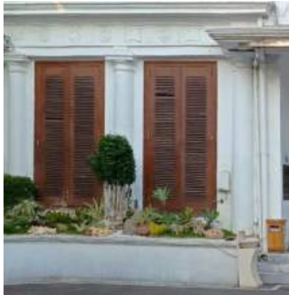
Gambar: Tampak kolom sisi samping Gedung Grahadi
