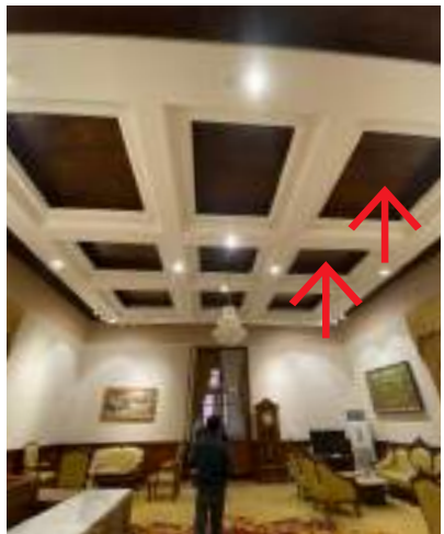
Gambar: Lokasi plafond kayu yang 'miring'.
