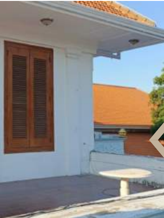
Gambar: Tampak Kolom Kotak Lantai 2
