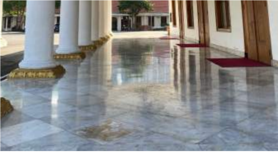
Gambar: Penutup Lantai Marmer di Area Teras Depan Lantai 1
