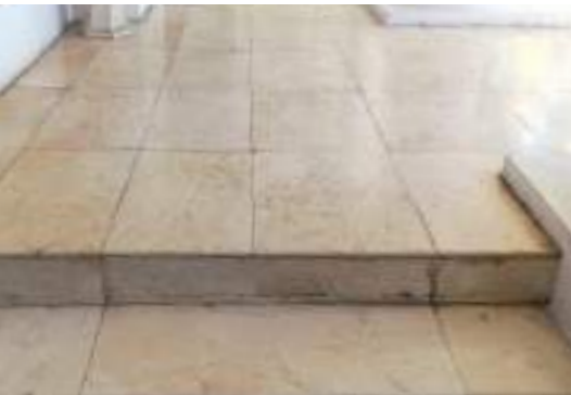
Gambar: Penutup Lantai Marmer di Area Teras Belakang Lantai 1
