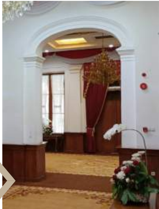
Gambar: Tampak Kolom Kotak Interior Lantai 1
